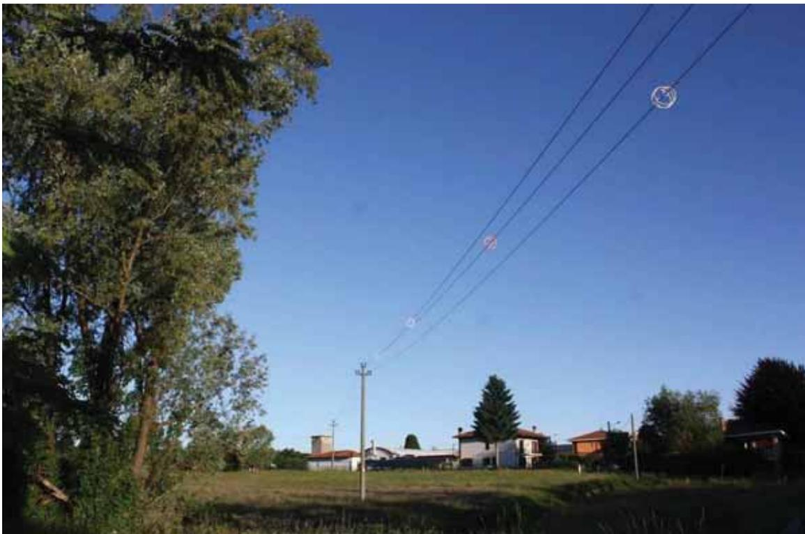
*Figura 4.20 – Linea aerea messa in sicurezza tramite posa di spirali nell'ambito del progetto LIFE "TIB", in provincia di Varese.*
