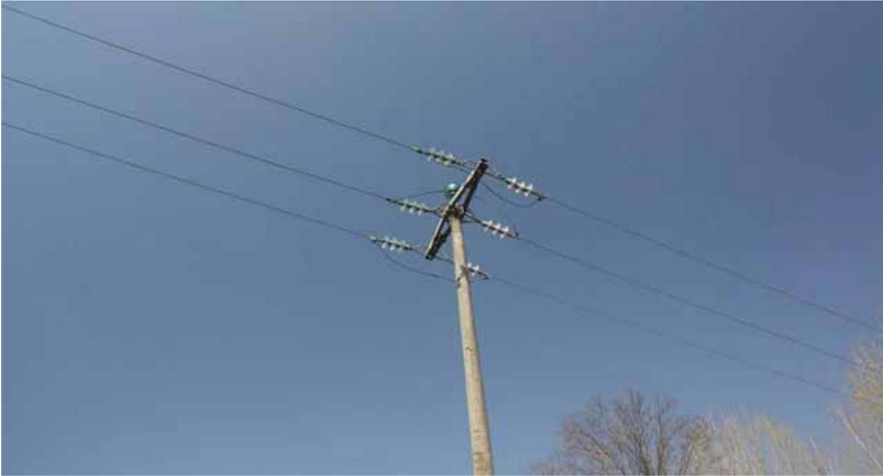
*Figura 4.45 – Particolare della linea descritta nel testo, dove si notano gli amari esposti, potenziale causa di elettrocuzione.*
